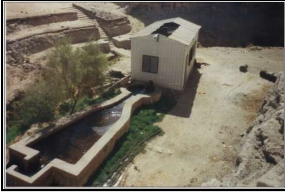
صورة (2) توضح بئر يتم الضخ به بواسطة ماكينة ويظهر الحوض والقنوات المنفرعة من البئر
